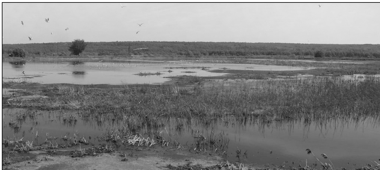
Рис. 1. Очистные сооружения г. Новочебоксарск.
