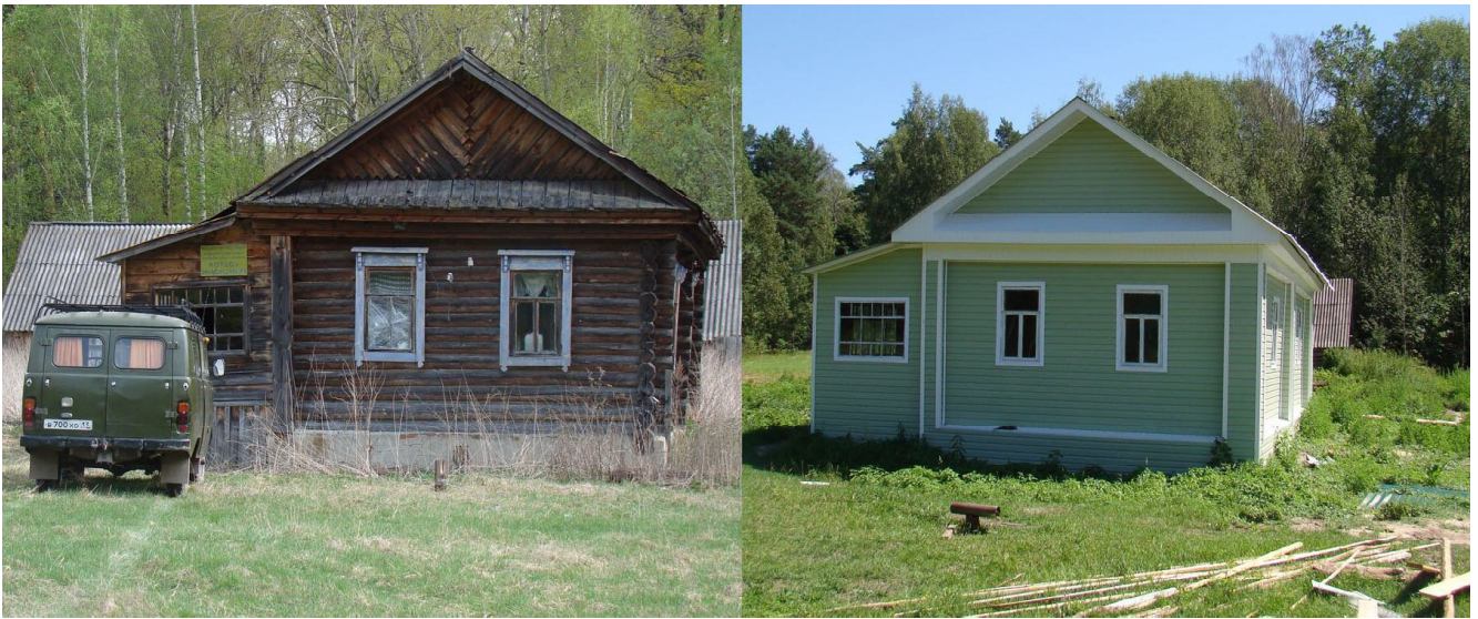
Инорский кордон до ремонта (2008 г.) и после (2011 г.)
