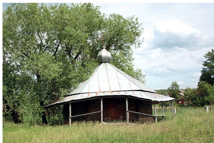
Купальня у источника в с. Елховка
